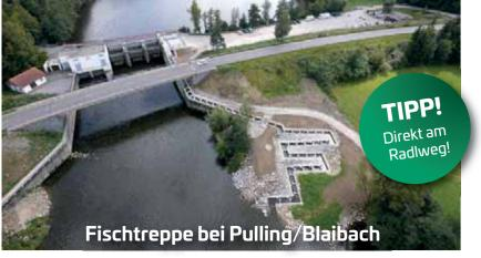
Die Fischwanderhilfe am Kraftwerk Pulling hat außergewöhnlichen Pilotcharakter für ganz Bayern, da das Baywerk als sogenannte große Talsperre (Stauvolumen, größer als eine Million Kubikmeter) und dessen 150 Meter langer Damm nun von der Fischtreppe durchquert wird. Die Fischwanderhilfe ermöglicht den Wasserlebewesen wieder ihre natürlichen Wanderbewegungen.
