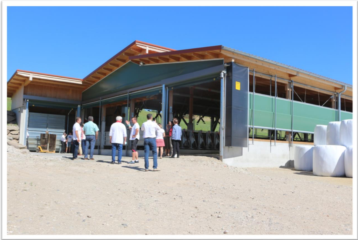
Besucher bei der Besichtigung des Rinderstalles;
