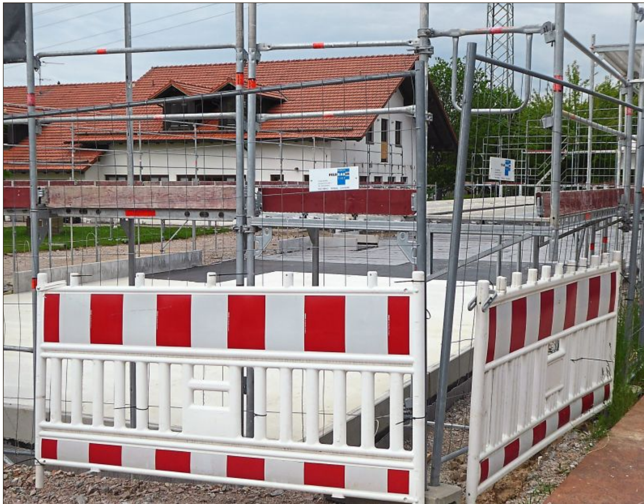
Der Kindergartenneubau, der wegen Lieferschwierigkeiten des Baumaterials ins Stocken gerät.
